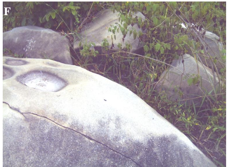
Photo F : Granite affleurant avec fissure ouverte et géodes d'altération (Axe Yamoussoukro-Sinfra, carrefour de Kékrenou)
