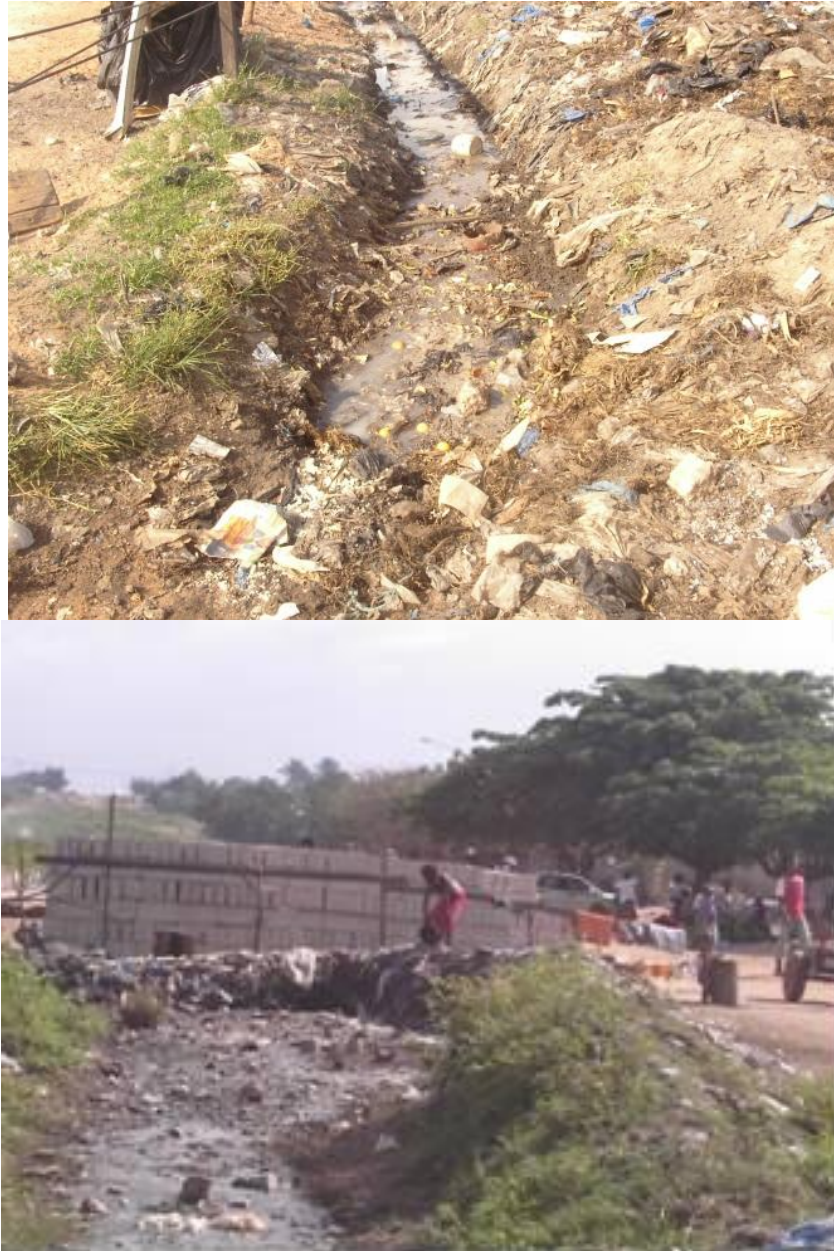
Planche 9 : Chenal d'écoulement des eaux usées et du lixiviat issu des ordures ménagères dans le quartier Dioulabougou (Yamoussoukro) (Photos G. Soro).
