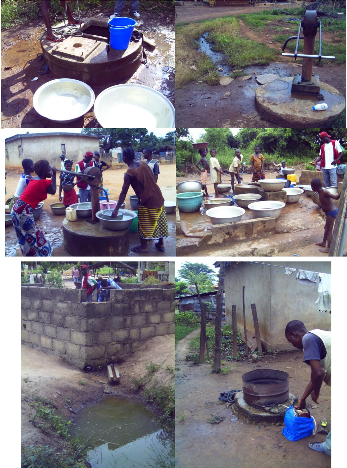
Planche 8 : Exemple d'ouvrages hydrauliques mal entretenus dans la région des Lacs, sources potentielles de pollution. (Photos : Soro G).
