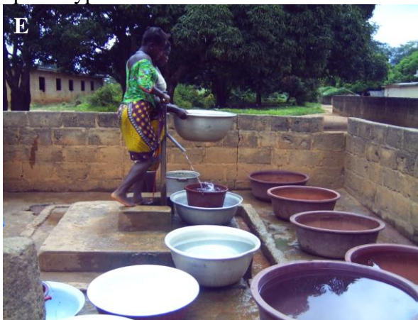
Photos : E et F : Forages équipés d'une pompe à motricité humaine type Vergnet à pédale
