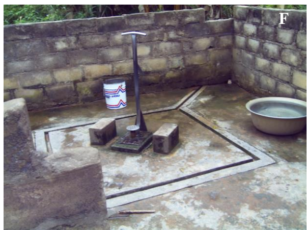
Photos : E et F : Forages équipés d'une pompe à motricité humaine type Vergnet à pédale
