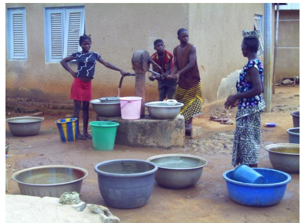
Photo D : Puits moderne équipé d'une pompe de type ASM
