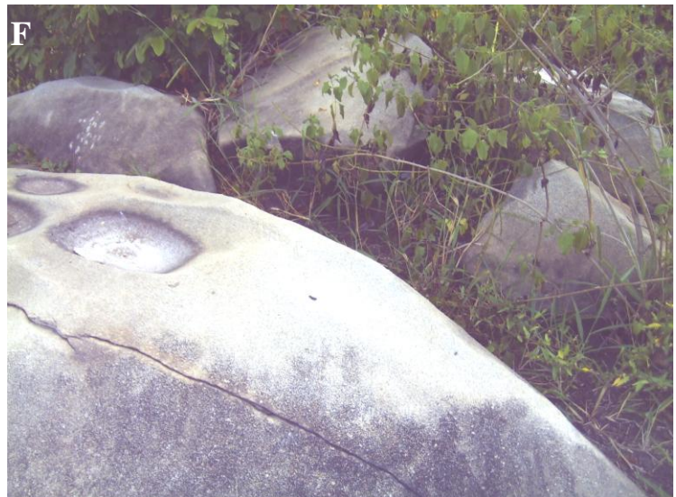
Photo F : Granite affleurant avec fissure ouverte et géodes d'altération (Axe Yamoussoukro-Sinfra, carrefour de Kékrenou)
